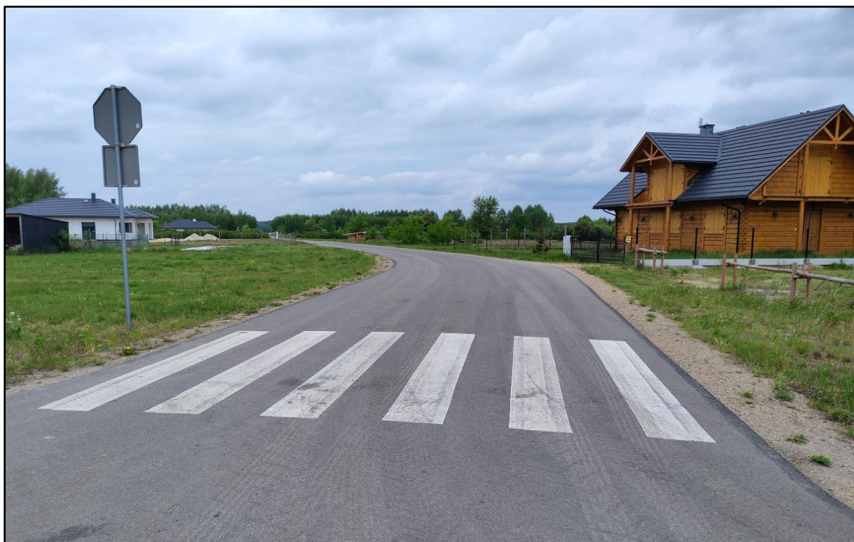
Fot. 1 Droga gminna zlokalizowana w miejscowości Jarocin
