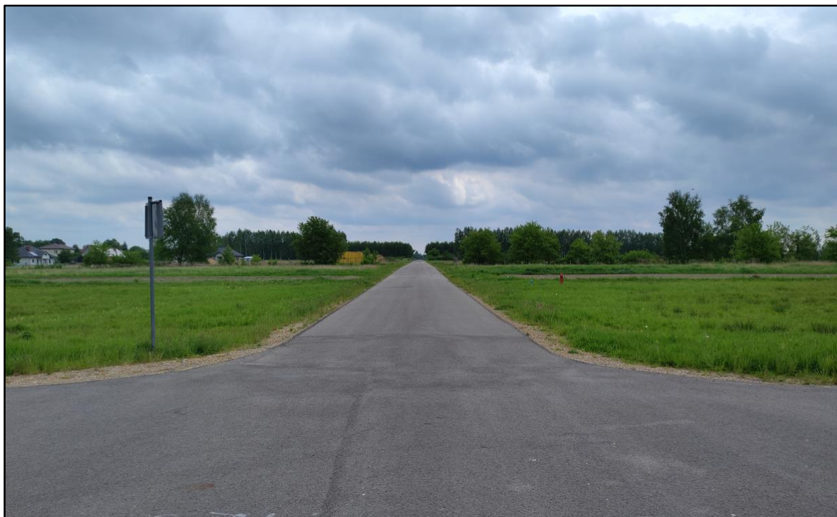
Fot. 2 Droga gminna zlokalizowana w miejscowości Jarocin
